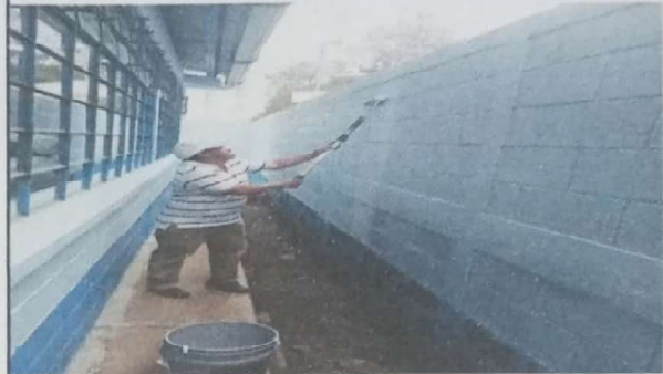
Foto 2: Mejoramiento de pintura en muros
