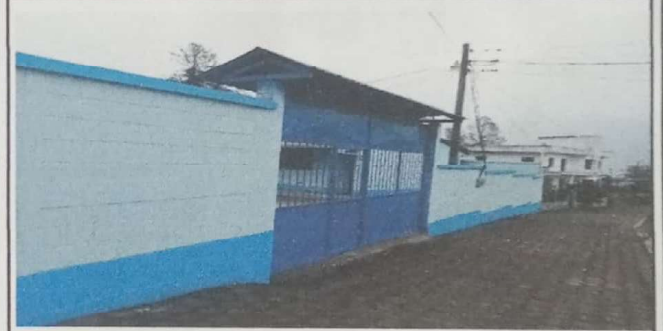
Foto 4: Remozamiento a porton de entrada principal
