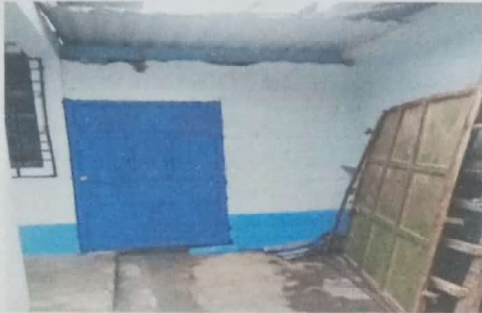
Foto1: Remozamiento de puertas
