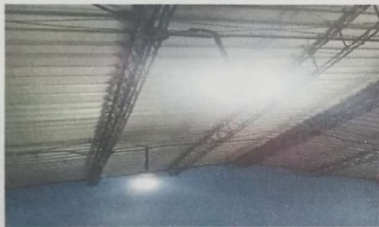
Foto 3: Mejoramiento de alumbrado eléctrico
