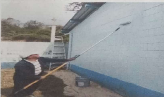
Foto 5: Mejoramiento de pintura de aulas
